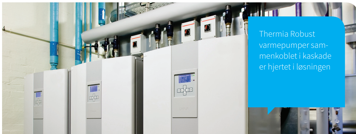
Varmepumper installeret i teknikrummet hos Danfoss i Silkeborg
