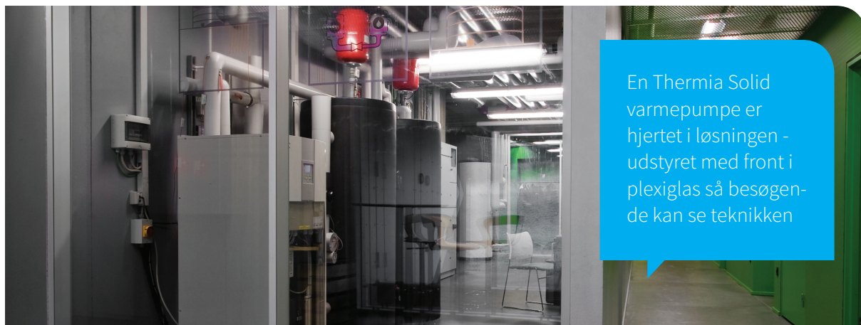
Varmepumper installeret i teknikrummet hos Naturvidenskabernes Hus i Bjerringbro
